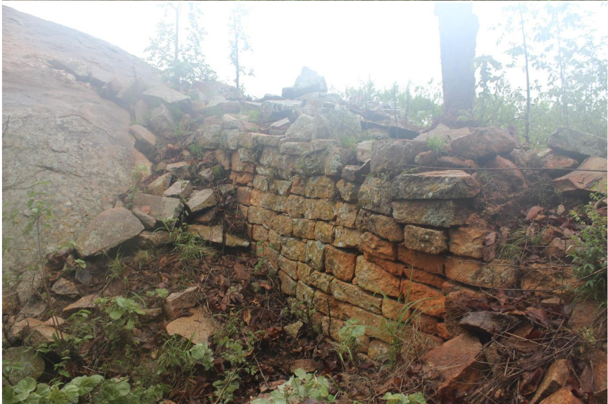
Walls 8a, and 9a
