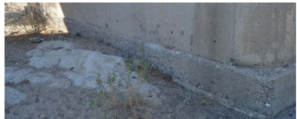
(d) Pile cap stripped of surface material
