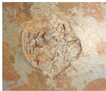
b) Spalling
