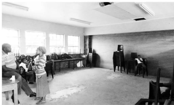
INADEQUATE FORUM SPACE Siyongisa Primary
