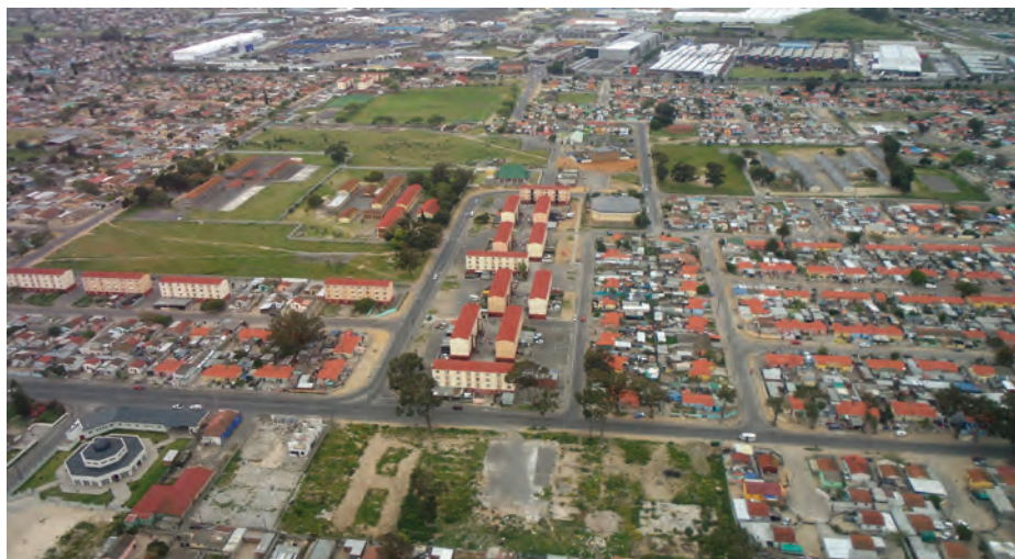
Fig 15 - Aerial view of Uitsig, 2013.
