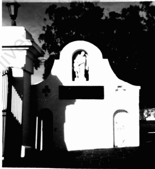
Die Duminy-grafkelder binne die ring- muur van die N.G.-kerk, Durbanville.
