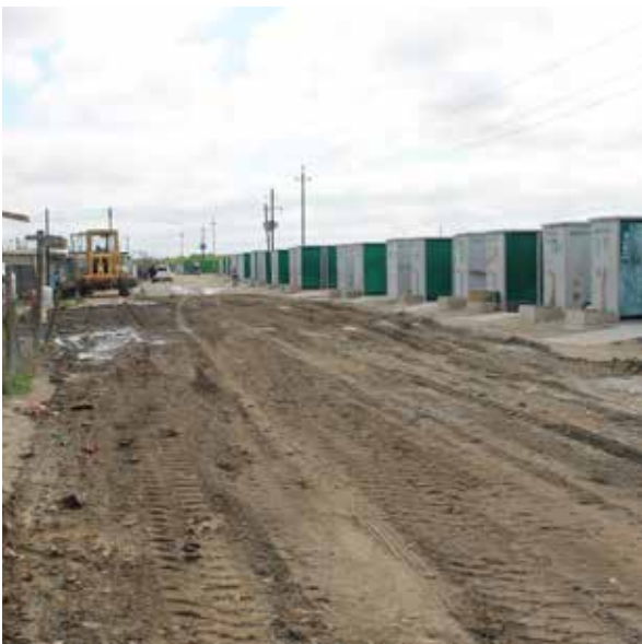
91 : Communal toilet blocks.
